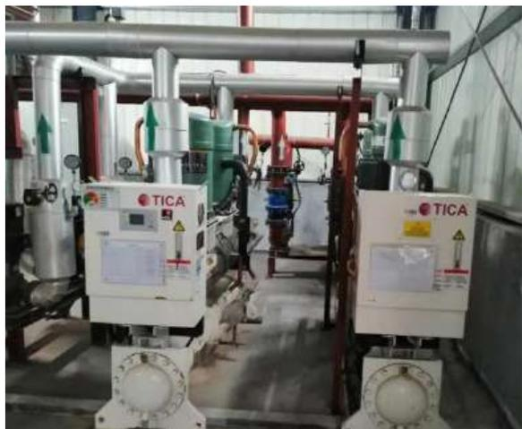
NMP 废气冷凝装置
